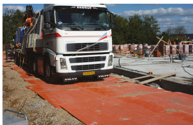
Stabiliserer underlaget og beskytter terrænet mod tung byggetrafik og maskiner.
